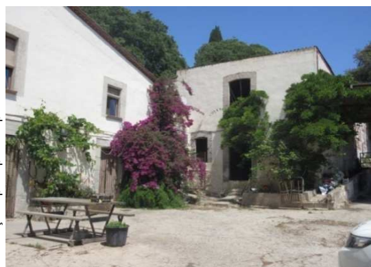
Façana principal i ampliació
